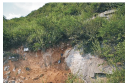
(a) 剖面照片 (a) Section photo
