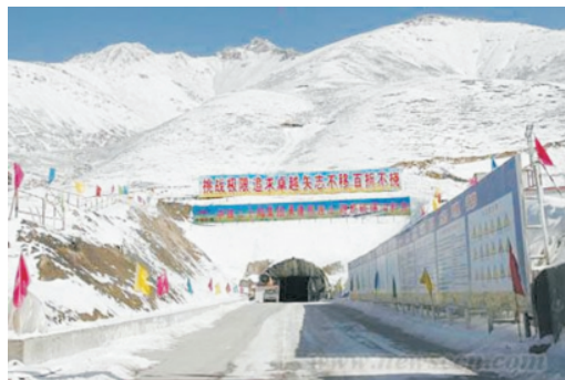
图 16 祁连山隧道入口(图片来源:中国建筑新闻网)
