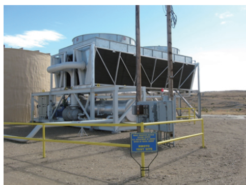
图 7 怀俄明 Rocky Mountain 油田试验中心的双工质装置从油田伴生地热水中获得热能
