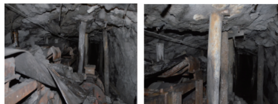
图 2 18 煤工作面回采后巷道破坏图
