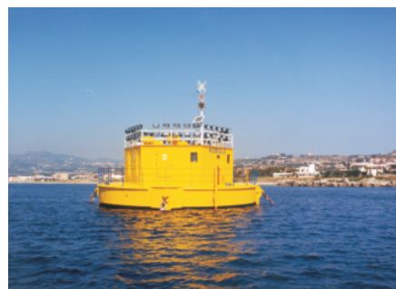
图 2 Kobold 型潮流能发电装置
