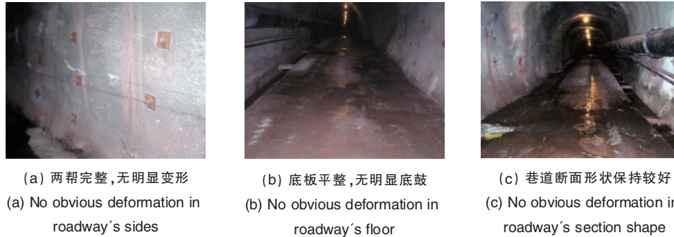
图9 应用联合支护方式的巷道现场照片
