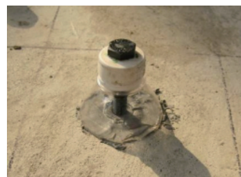
图3 钢质锚固件埋设
