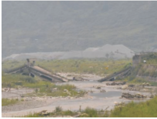
图 12 原小鱼洞大桥坍塌 Fig. 12 Collapsed Xiaoyudong bridge
