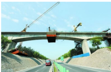
图 14 世界上最长的单体预应力混凝土连续梁—— 滹沱河特大桥跨京广铁路连续梁 (图片来源:中国铁路网)
