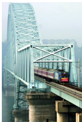
图 24 万州铁路大桥 (图片来源:新民网)
