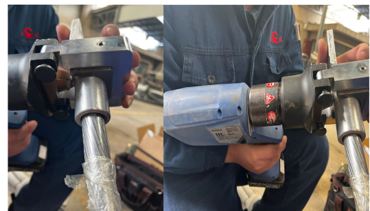
(b) 压接过程现场照片
