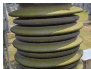
图1 生长苔藓的输变电设备外绝缘表面
