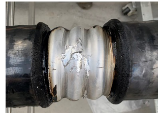
图11 电缆铝护套修复示意图
