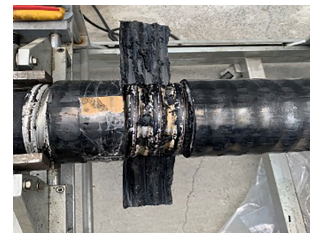
图6 外护套去除过程示意图
