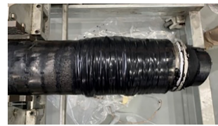
图12 电缆外护套修复效果图
