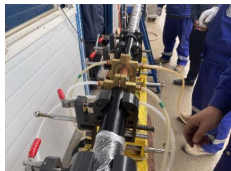
图5 110 kV 高压电缆熔接头现场制作
