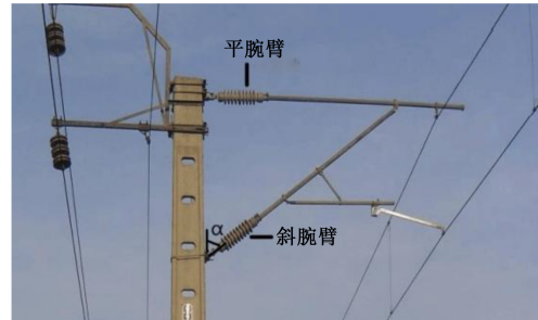
图2 腕臂绝缘子布置图
