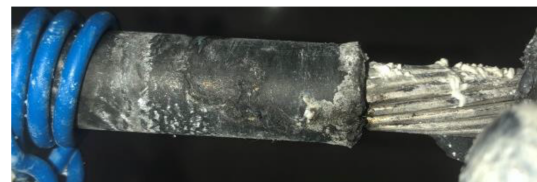
图11 线夹包覆处绝缘导线表面烧蚀现象
