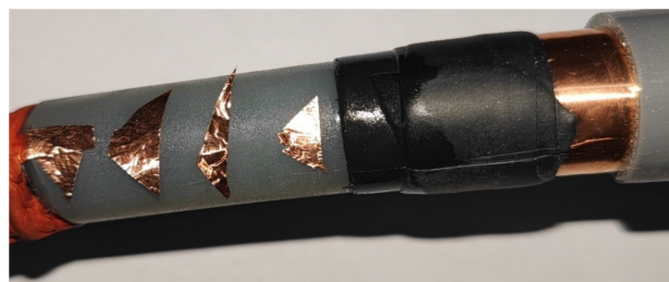
图3 中压电缆终端界面缺陷
