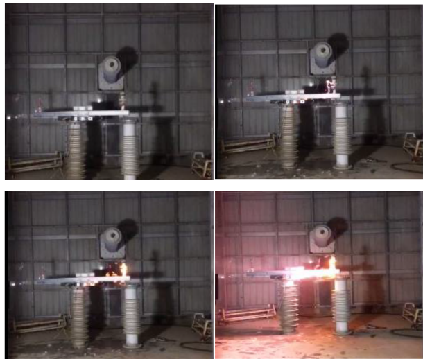
图4 10 kV方管复合绝缘横担污秽覆雪闪络过程 (覆雪厚度为10 mm)
