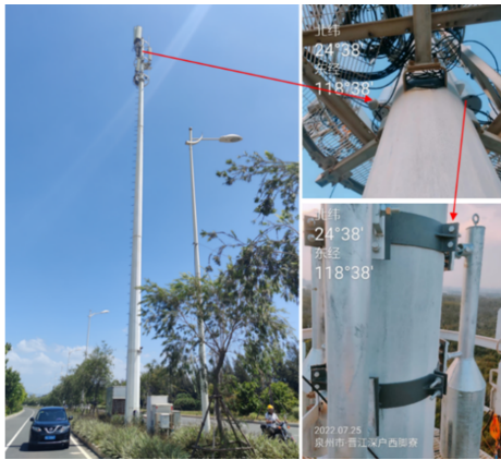
图 14 阻尼器安装形式
