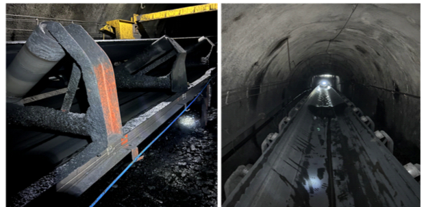
图 15 皮带下山带式输送机倾角现场
