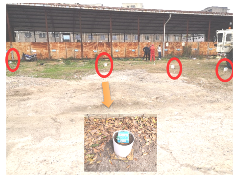
图12 水泥路面激振试验场地
