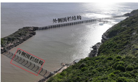
图2 外侧与内侧围栏结构
