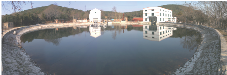
图1 爆炸水池 Fig. 1 Explosion pool
