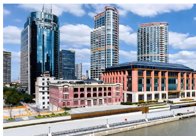
图8 “红楼”托换顶升后实景
