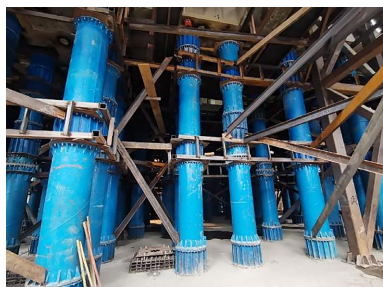
图 6 超长顶升支撑加固照片
