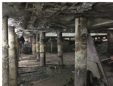
图10 地下开挖实景
