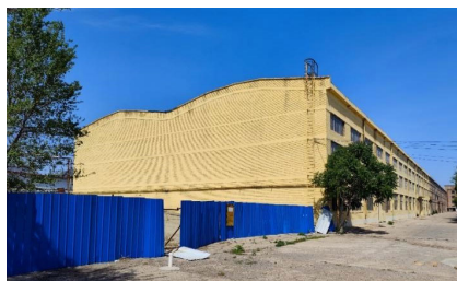
图36 改造更新前建筑西立面
