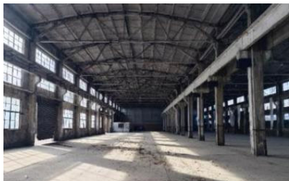
图 12 厂房原内部空间
