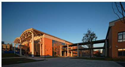
图35 改造更新后C10主入口
