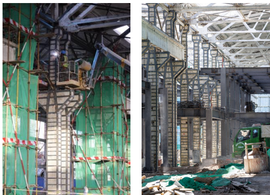
图 27 包钢加固现场 Fig. 27 Steel jacketing construction site
