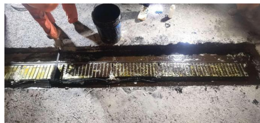
图 14 接缝构件铺设
