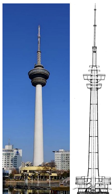
图1 某电视塔建筑立面、剖面
