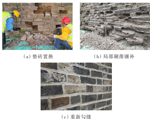
图 15 墙体风化修缮施工工艺
