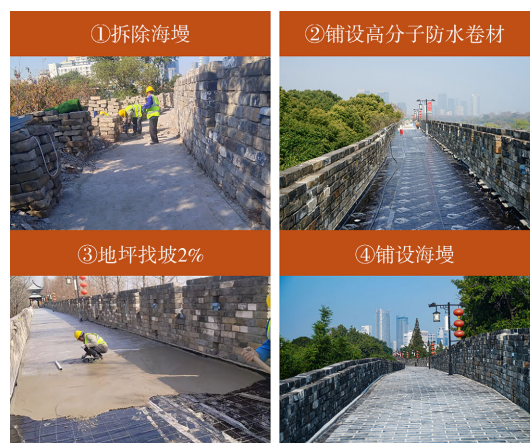
图 19 海堤加固修缮施工工艺流程
