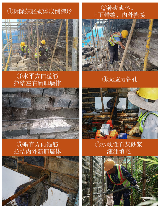
图 12 鼓胀病害修缮施工工艺流程
