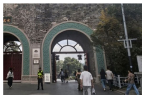
(b) 拱券贯穿锚固修缮后
