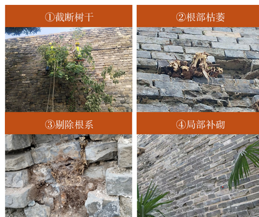
图 17 生物危害修缮施工工艺流程
