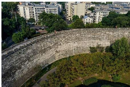
图 4 南京城墙解放门至玄武门段墙体外侧照片
