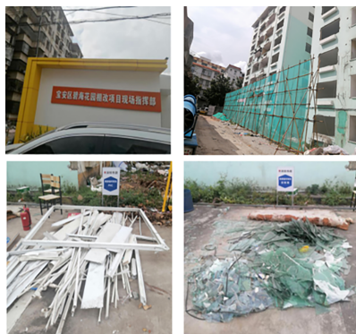
(a) 拆除废弃物分类存放
