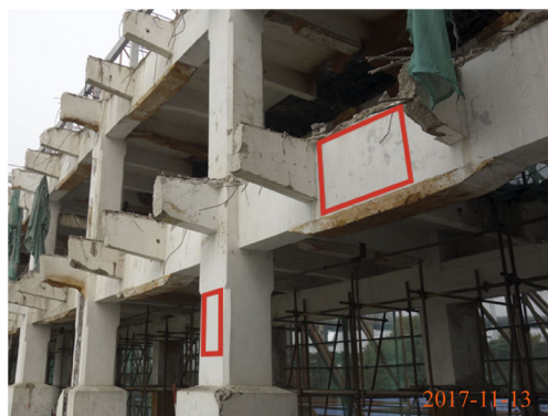
图 1 和记洋行钢筋混凝土框架上取样位置
