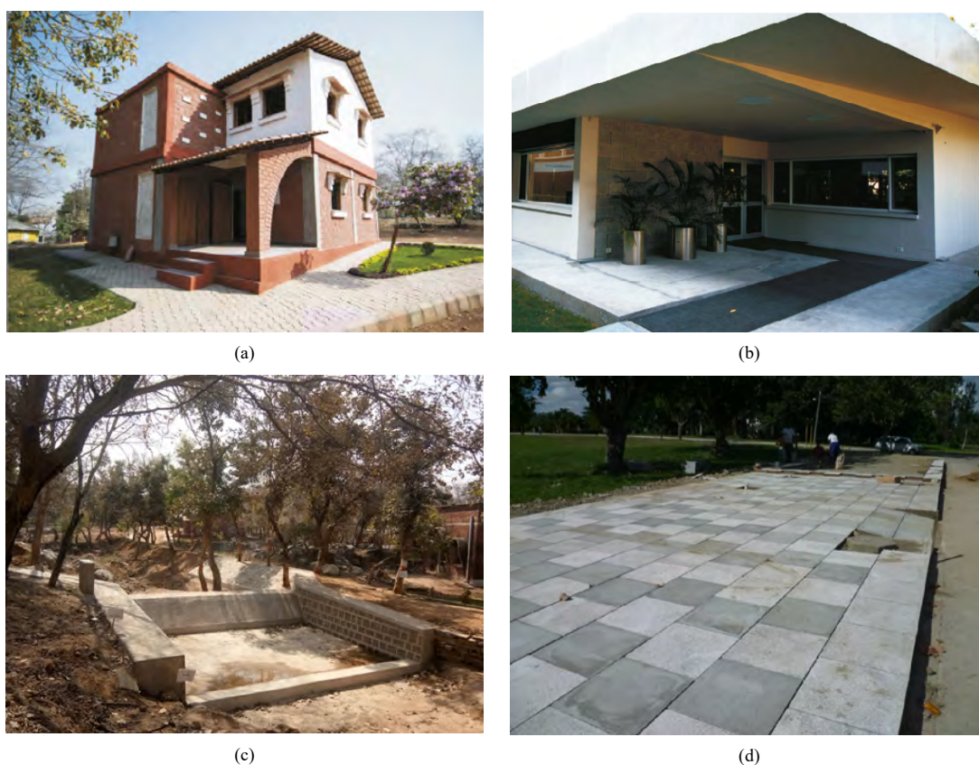
图 19 LC^3 作为建筑材料的工程应用示例: (a)印度占西地区房屋模型, (b)瑞士驻德里大使馆, (c)印度奥尔恰地区河坝, (d)古巴 UCLV 人行道路面 [112]
