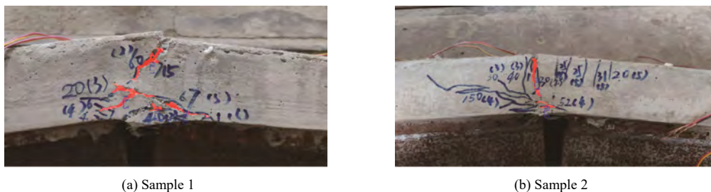
图 17 FRP 筋增强 ECC 连接板的板厚方向的裂缝识别图
