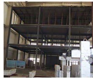
(b) 整体试验楼
