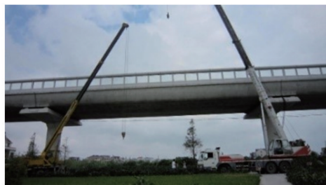
(a) 测试现场桥下场景
