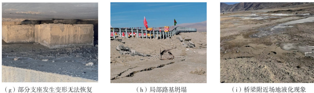
图3 G219 噶定线杂村二号桥震害
