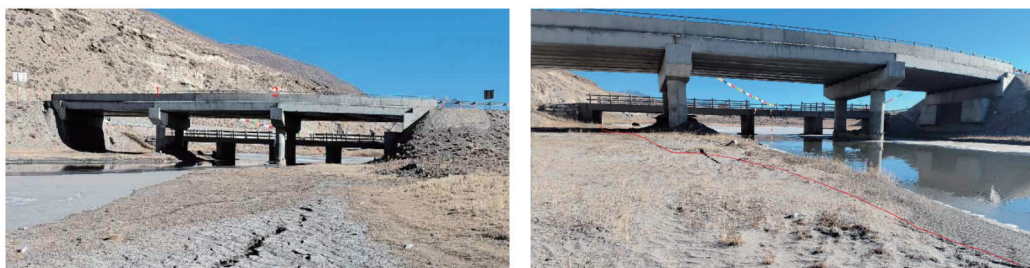
(a) 桥梁整体及桥墩
