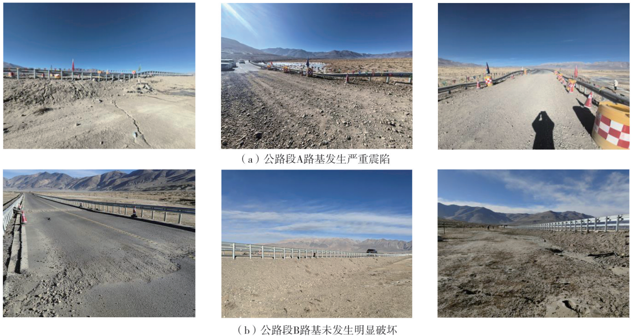
图 6 疑似场地液化导致路基不同程度破坏现象
