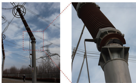
图 1 2023 年积石山地震避雷器震害
