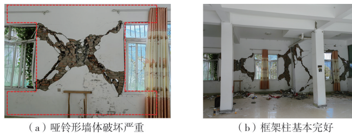
图 18 哑铃形构件和框架柱构件震害
