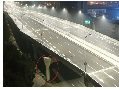
图 1 城市桥梁桥墩偏心设置
