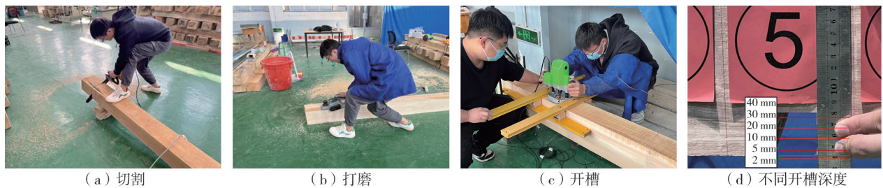
图10 木梁开槽现场图
