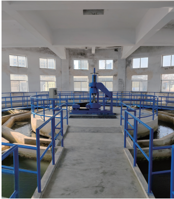
图9 机加池内的刮泥机
