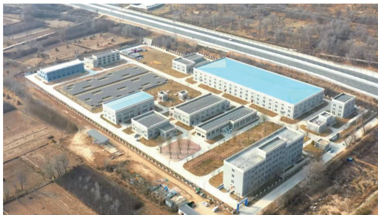
图1 临夏市新庄水厂
