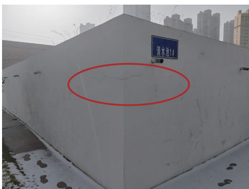
图13 肖家水厂1号清水池
