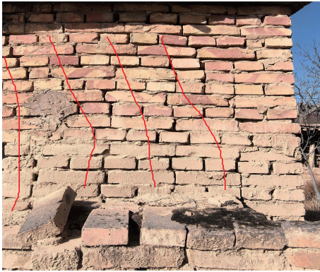
图 14 墙体顺缝砌筑
