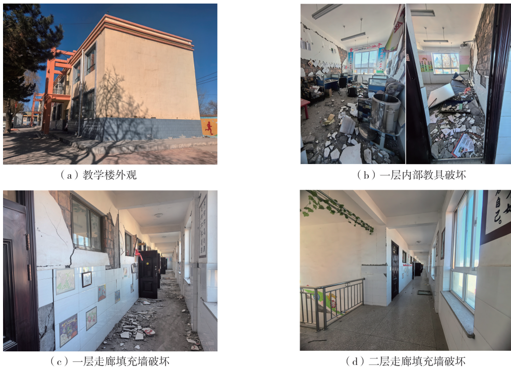
图 9 石塬村小学教学楼
