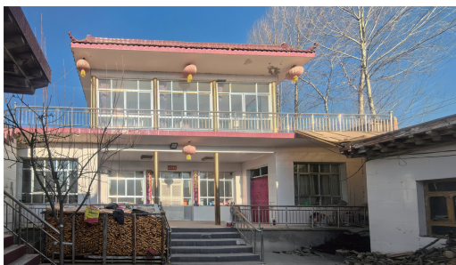
(a) 二层砖混结构民居外观
