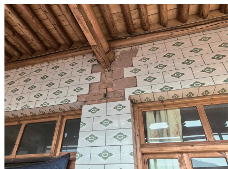
图 13 无圈梁构造柱
