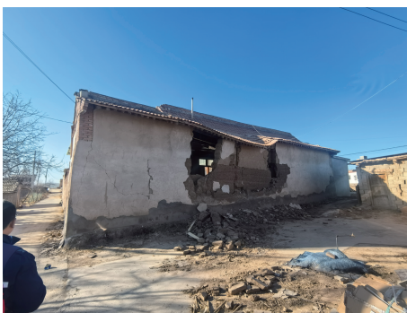
图 16 砖柱土墙木屋架房屋
