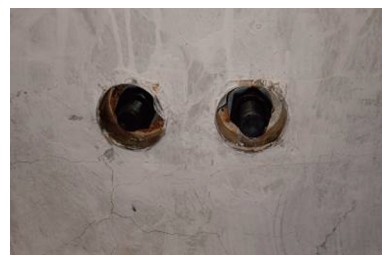
图 22 裂缝扩展情况(荷载 750 kN)
