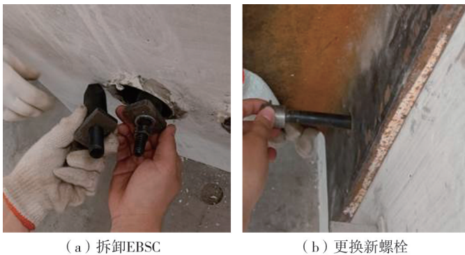
图 19 试验中的拆换过程
