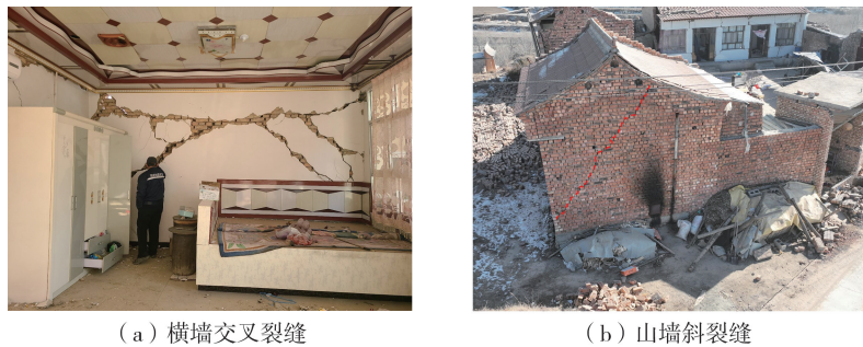
图 7 墙体斜裂缝
