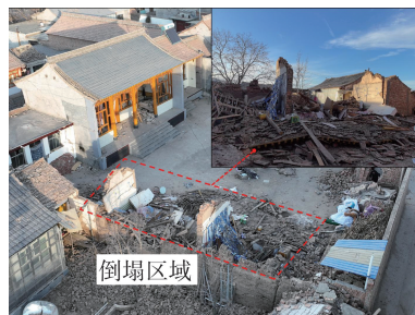
图 4 砖木结构整体倒塌(刘集乡高李村, VIII 度)
