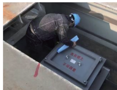
图 11 TMD 现场安装示意图 Fig. 11 Schematic diagram of TMD on-site installation
