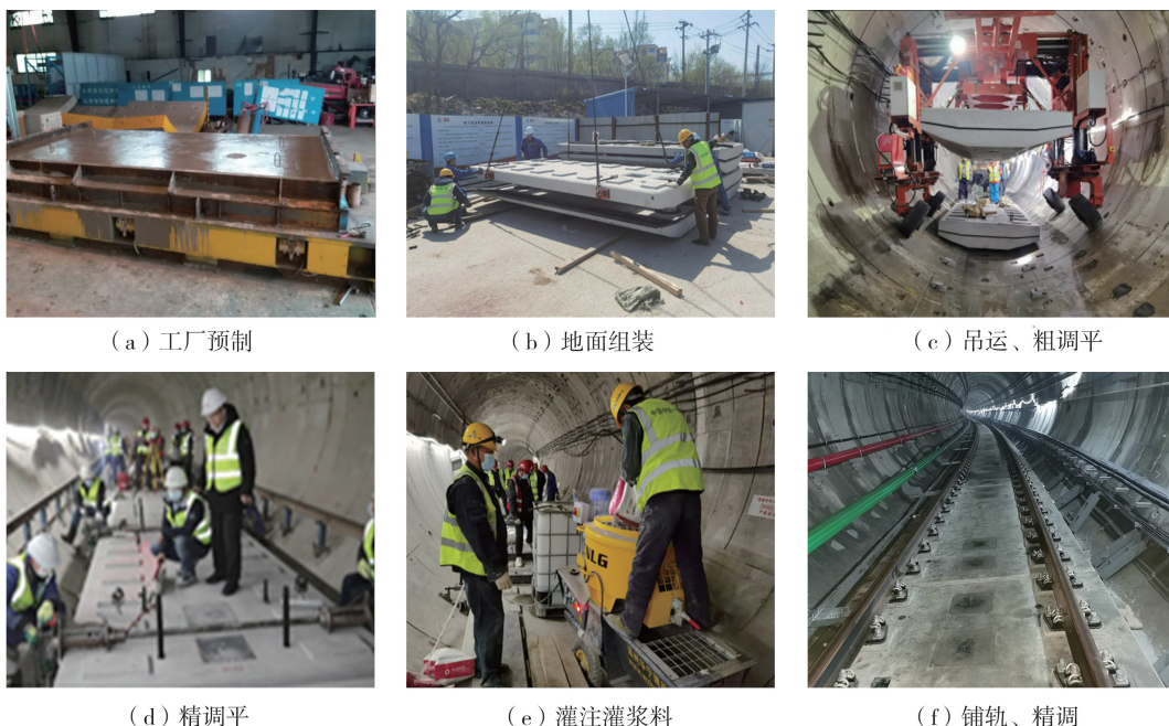
图 3 PDPFST 施工工艺
