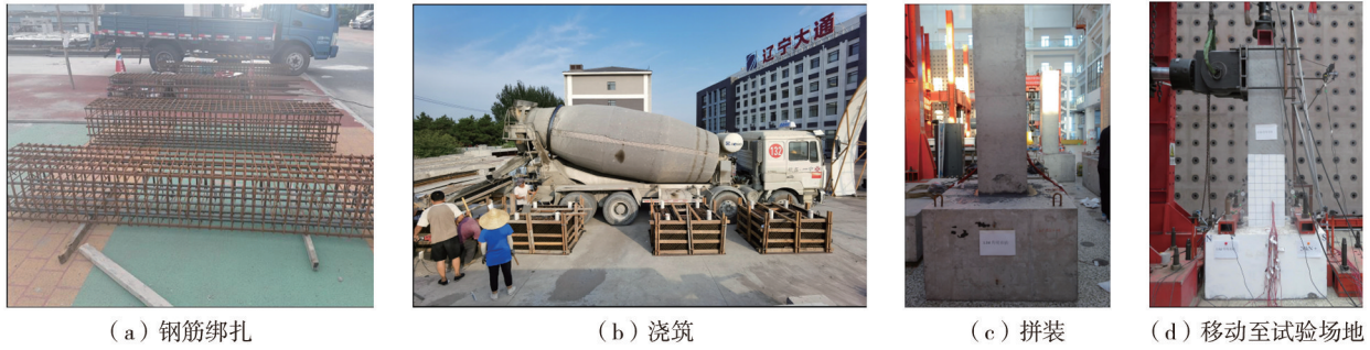
图 4 承插试件制作流程
