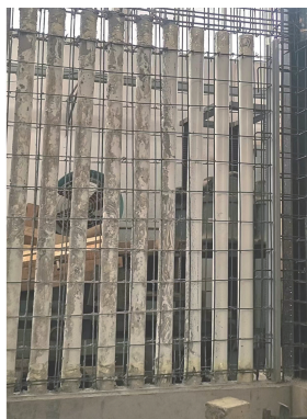
(a) 钢筋笼整体
