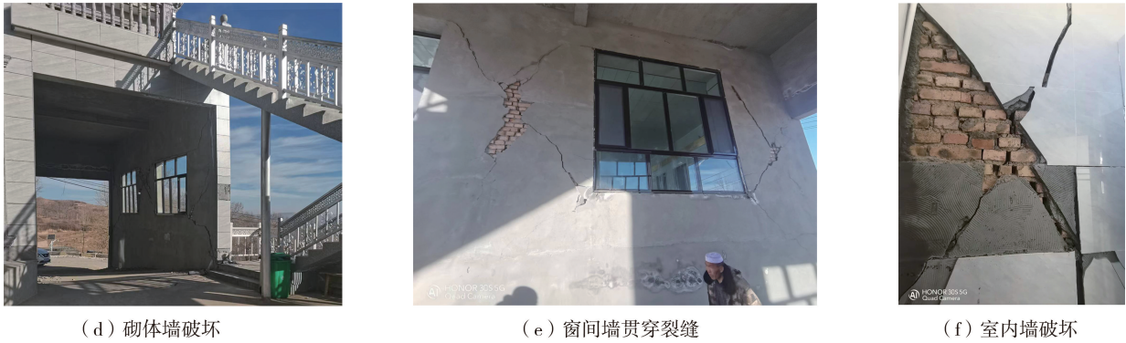
图 2 砖混结构的典型破坏
