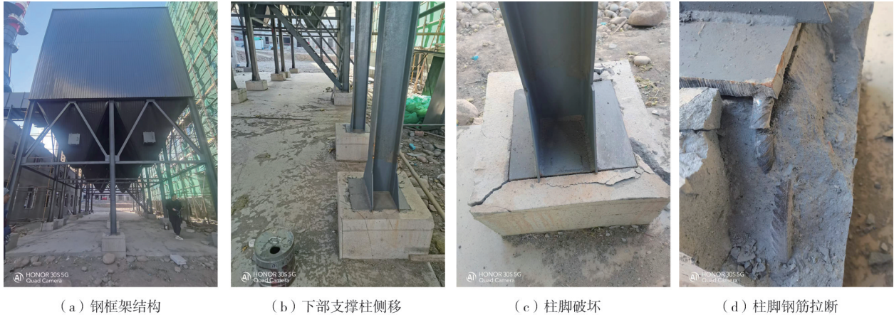
图10 钢结构典型破坏
