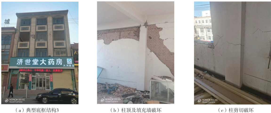
图9 底框结构典型破坏模式3
