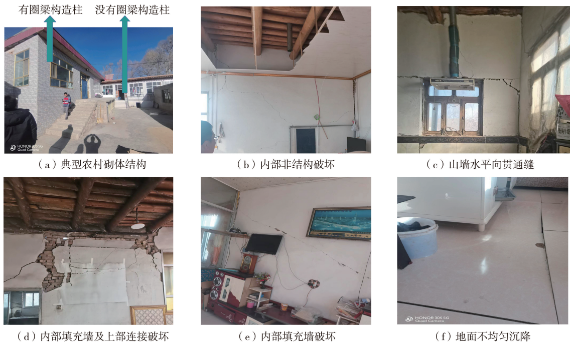
图 3 农村砌体结构的典型破坏
