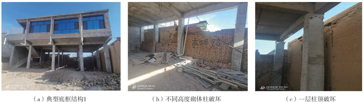
图 7 底框结构典型破坏模式 1
