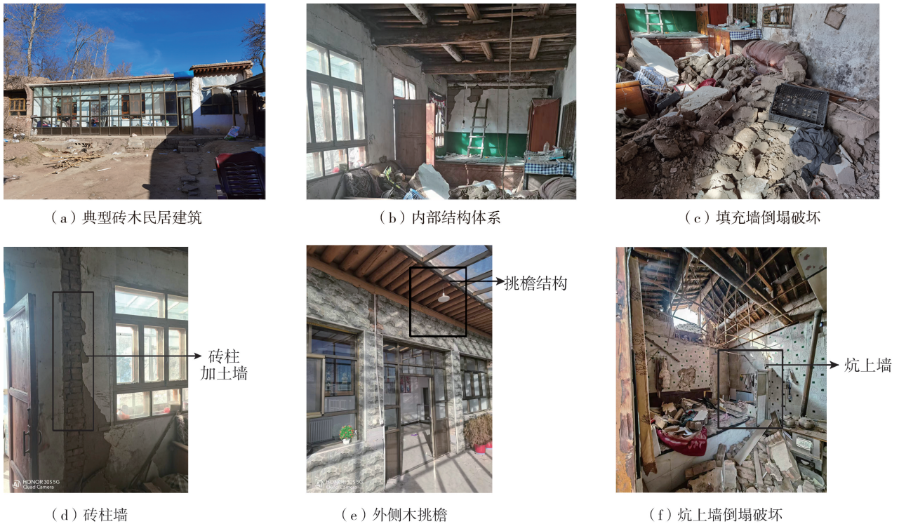
图1 砖木结构的典型破坏
