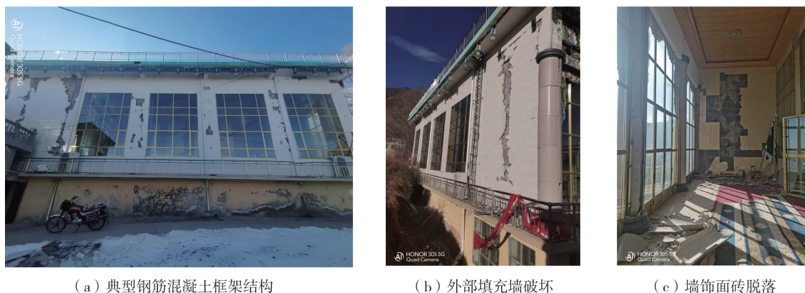
图4 钢筋混凝土框架结构的典型破坏
