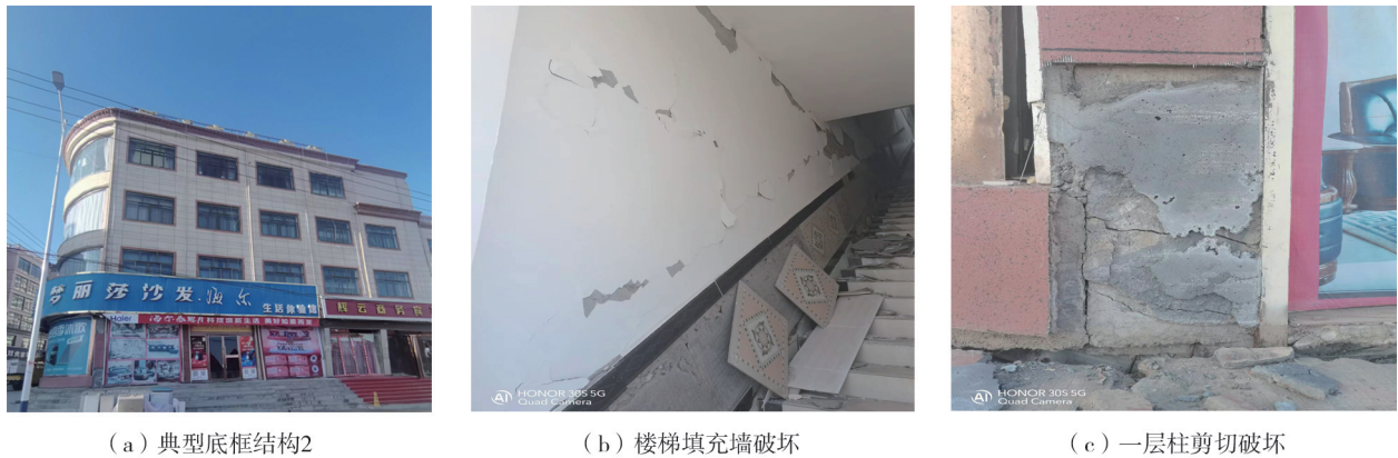
图8 底框结构典型破坏模式2
