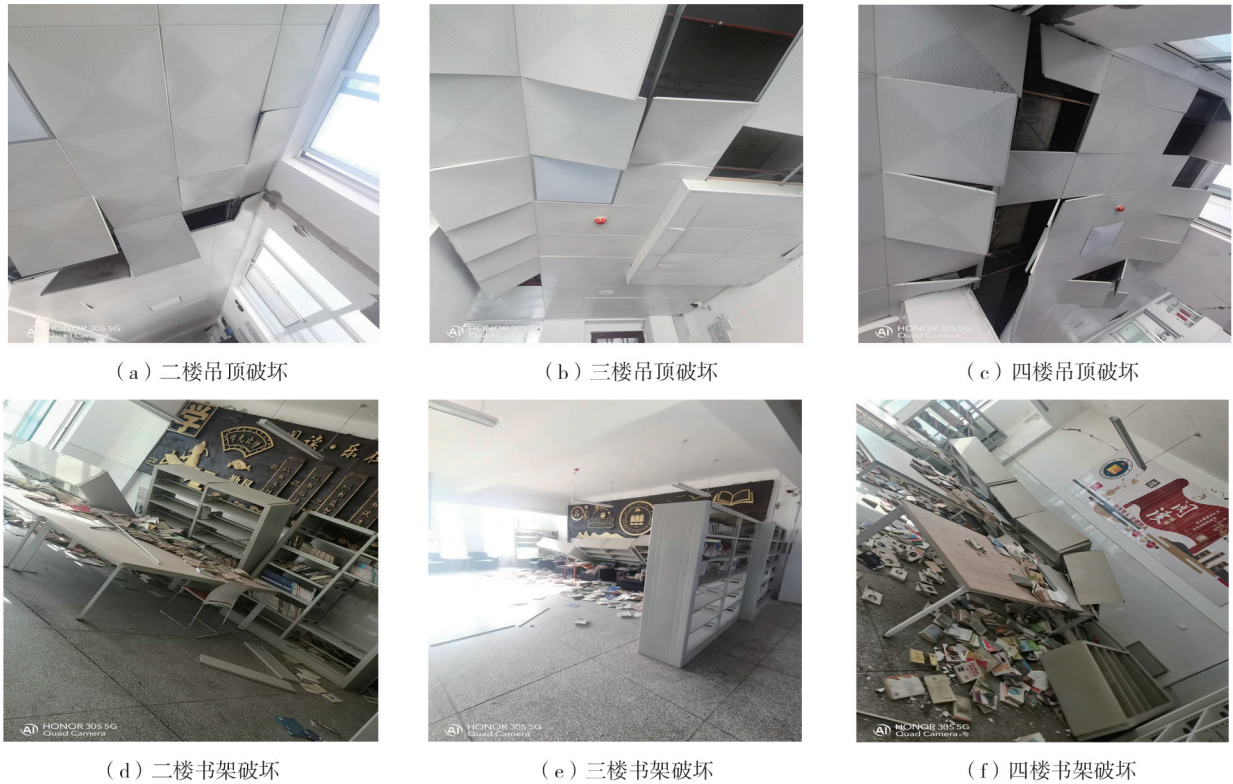
图 6 典型非结构破坏
