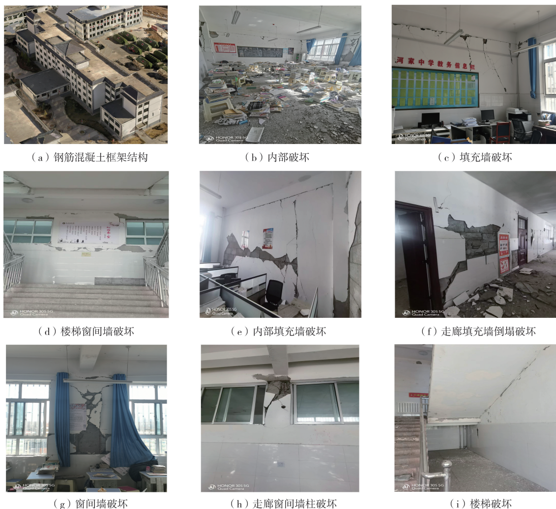
图5 学校类钢筋混凝土框架结构的典型破坏
