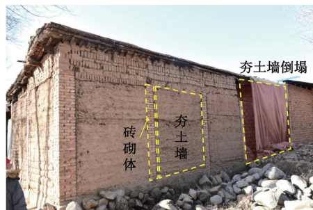
图 22 红崖村设置砖柱的夯土墙体
