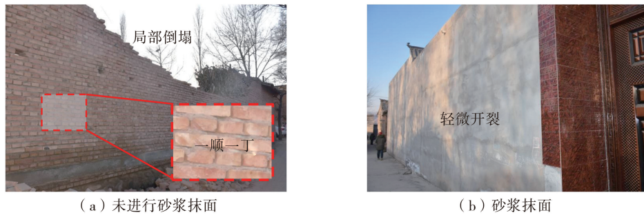
图23 陈家村围护墙体破坏特征
