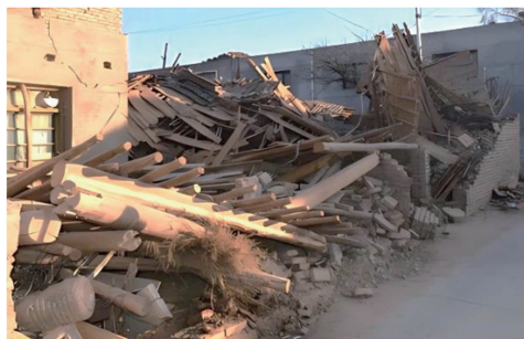
图13 陈家村整体倒塌的砖木结构民居
