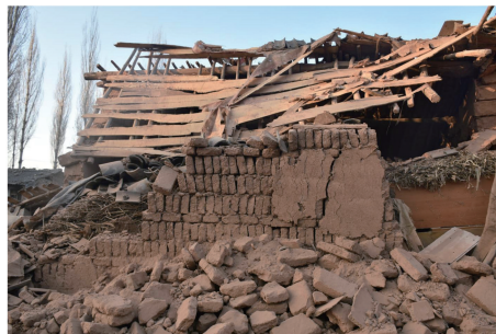
图 19 陈家村整体倒塌的生土结构民居
