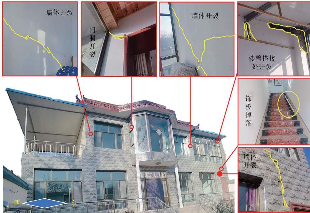
图 18 红崖村某二层砖混结构民居
