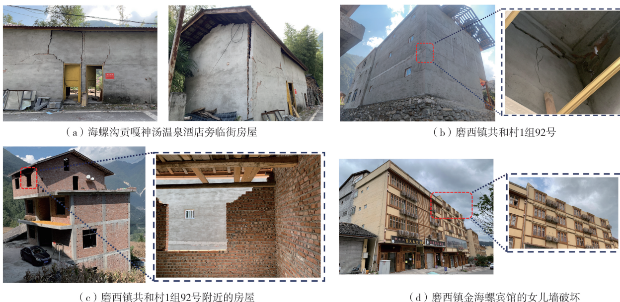
图2 具有“散”特征建筑的震害
