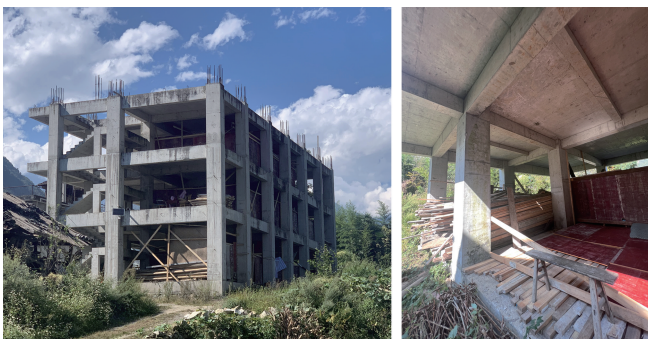
(a) 磨西镇共和村某在建框架
